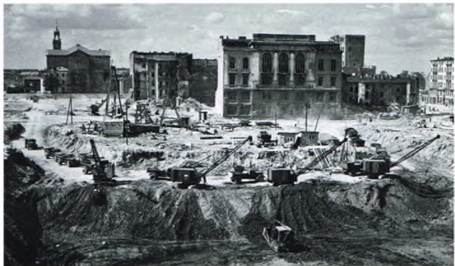
Wykop pod fundamenty PKiN. Rok 1952
