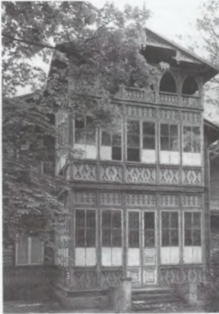
Dawne sanatorium A. Gurewicza w Otwocku – stan przed remontem
