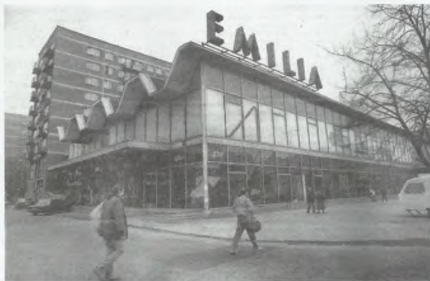
Pawilon „Emilia” z charakterystycznym pofalowanym dachem. Przez lata był w nim sklep meblowy
