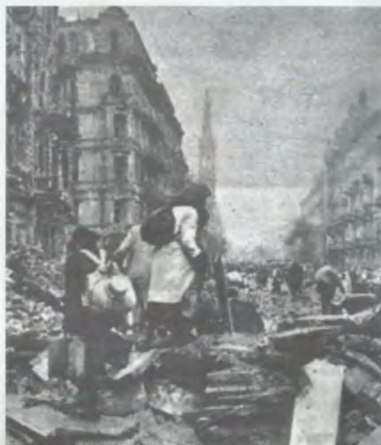
Ewakuacja ludności cywilnej do obozu przejściowego w Pruszkowie
