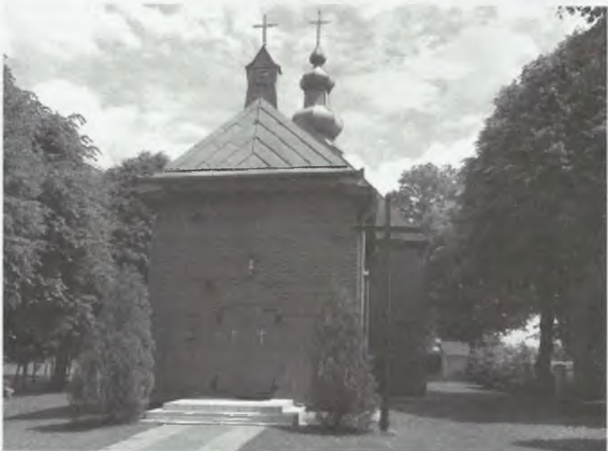
Odnowiona elewacja świątyni w Żółkiewce
