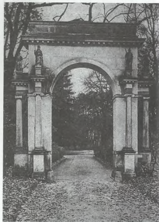
Łuk triumfalny na cześć księcia Józefa Poniatowskiego. Budowla powstała dzięki księżnej Annie z Tyszkiewiczów (siostrzenicy księcia „Pepi”)
