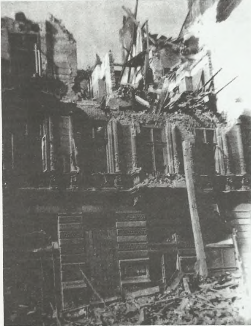
Zniszczone budynki w centrum Warszawy (ul. Marszałkowska)
