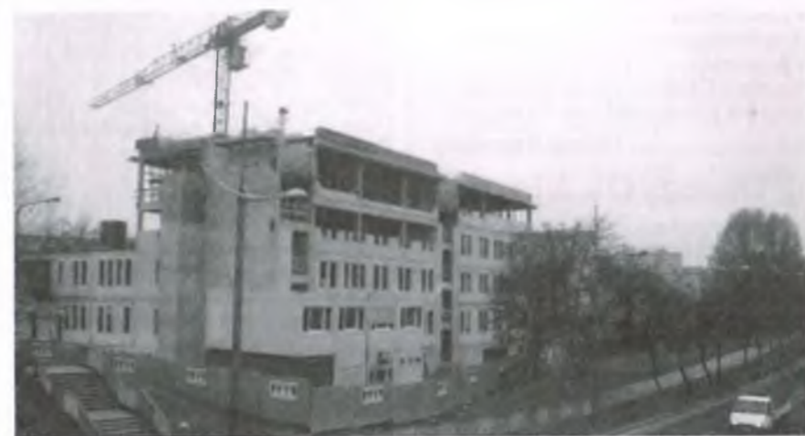
Częstochowskie Centrum Medyczne w budowie
