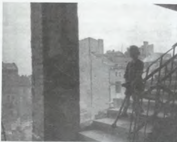
Domy bez ścian. Dobrze, że były balustrady przy schodach i jest się czego trzymać
