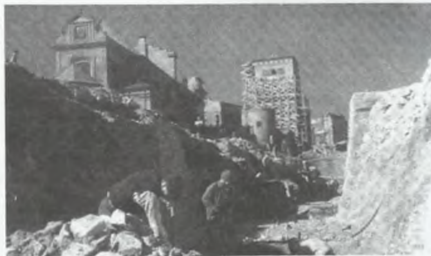
Wykop pod wjazd do tunelu trasy W-Z — po lewej widać fundamenty starych budynków
