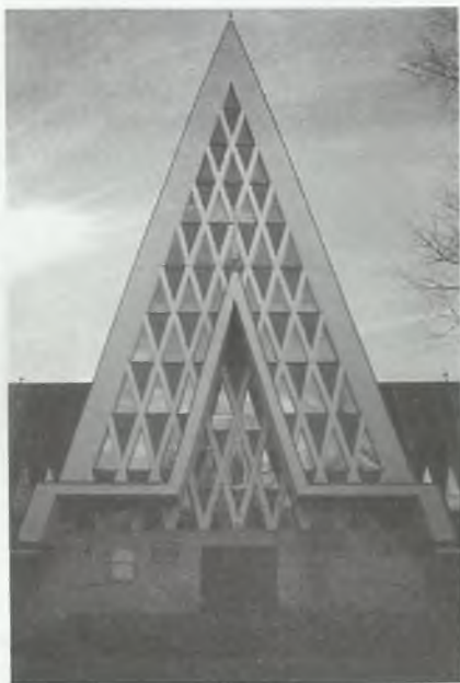
Wieża kościoła została pięknie odnowiona. Na zdj. widoczny nowy krzyż i oświetlenie obrazu Matki Bożej, umieszczonego tuż nad wejściem
