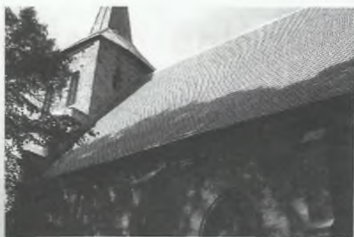
Nowy dach kościoła w Bukowie Morskim
