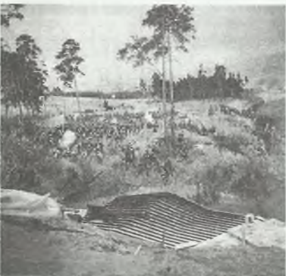
Prace przy kształtowaniu sztucznego terenu (sztafażu)
