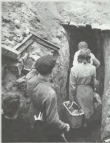
Tunel pod ul. Czerniakowską
