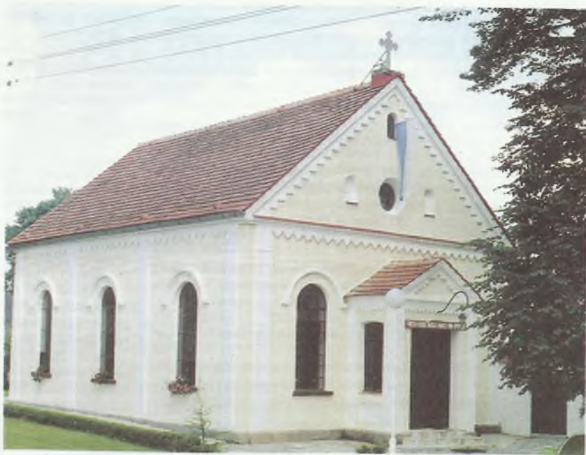
Po kilku latach ukończono remont kapitalny budynku kościoła
