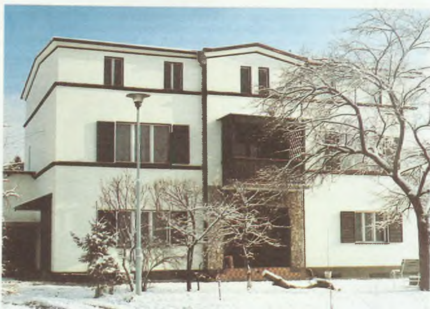
Plebania — również po kapitalnym remoncie
