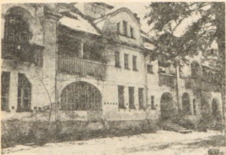
3. Pensjonat „Odpoczynek” — brak mieszkań dla lokatorów uniemożliwia podjęcie prac konserwatorskich przez właściciela (SARP)
