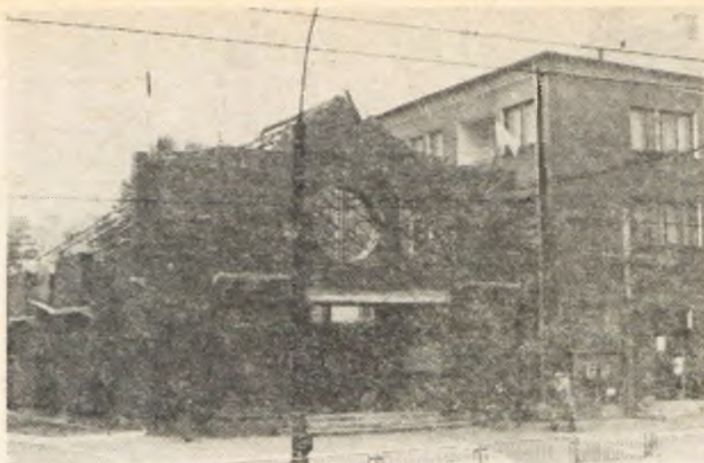
Kościół pw. Wniebowzięcia NMP w budowie
