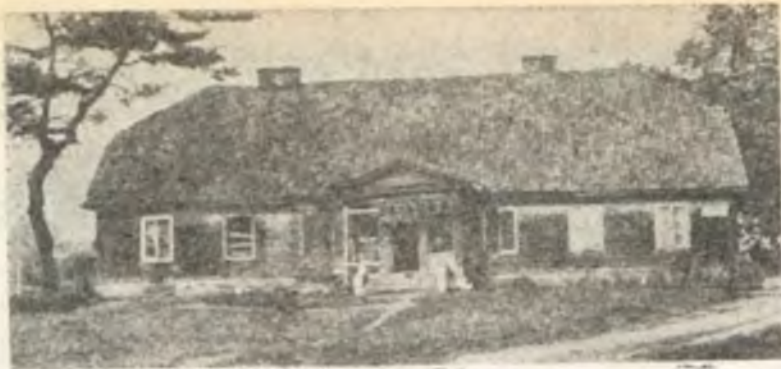
Elewacja frontowa dworu w Osieku
