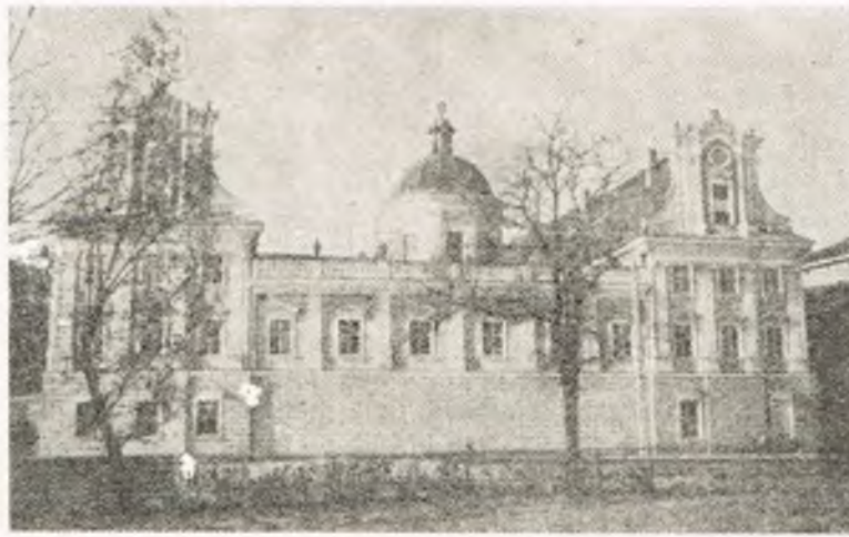
Biblioteka Zakładu Narodowego im. Ossolińskich we Wrocławiu
