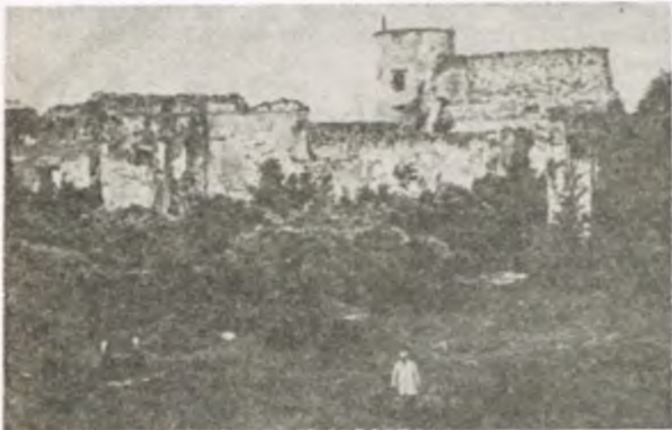
JANOWIEC. Ruiny renesansowego zamku na wysokiej skarpie lewego brzegu Wisły. Należał do rodziny Firlejów, Tarłów i Lubomirskich. Zaczął padać w ruinę na przełomie XVIII-XIX w., w latach 1809—1813 zdewastowany przez wojska austriackie i rosyjskie. Największe zniszczenia spowodowały obie wojny światowe. Do roku 1975 — jedyny prywatny zamek w Polsce, należący od 1927 roku do pana Leona Kozłowskiego, którego pragnieniem było uratowanie od ostatecznej ruiny ocalałych fragmentów.
