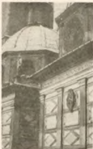
Kaplica Zygmuntowska. Fragment kopuły z oknem i latarnią.
