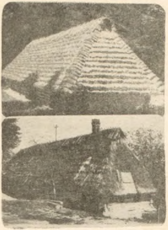
Odtworzona bez użycia gwoździ chata w Biskupinie, zbudowana 2500 lat temu w osadzie nawodnej oraz autentyczna chata zabytkowa z osiemnastego wieku, różniąca się od biskupińskiej jedynie tym, że posiada urządzenie kominowe, zabudowany odgromnik przed pół wiekiem (ok. 1835 r.) i obecnie antenę radiową i telewizyjną
