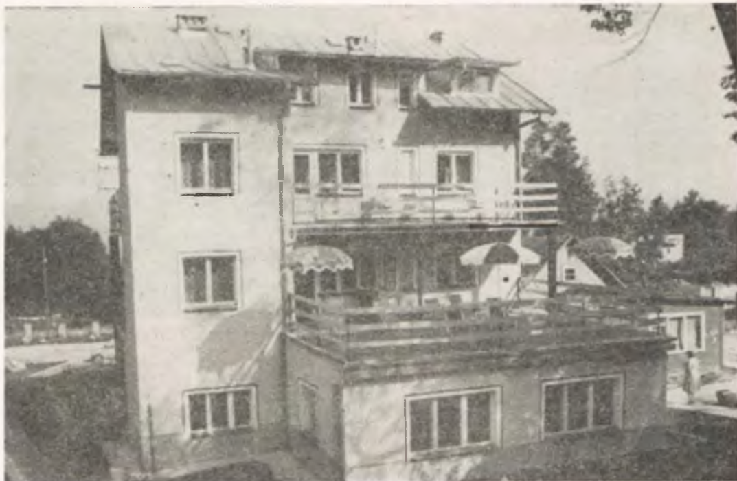
Budynek główny Ośrodka
