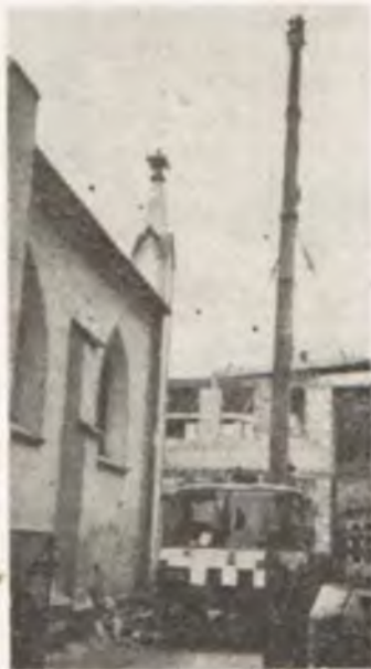
Prace przy budowie plebanii
