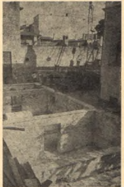
3-4-5 Zdjęcia najlepiej ilustrują dobre tempo budowy nowej plebanii
