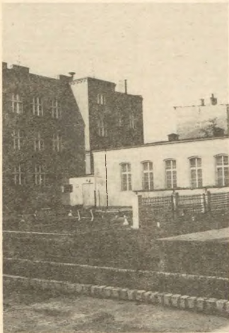
Budynek Zakładu Wychowawczego dla Dzieci Niedosłyszających w Szczecinie
