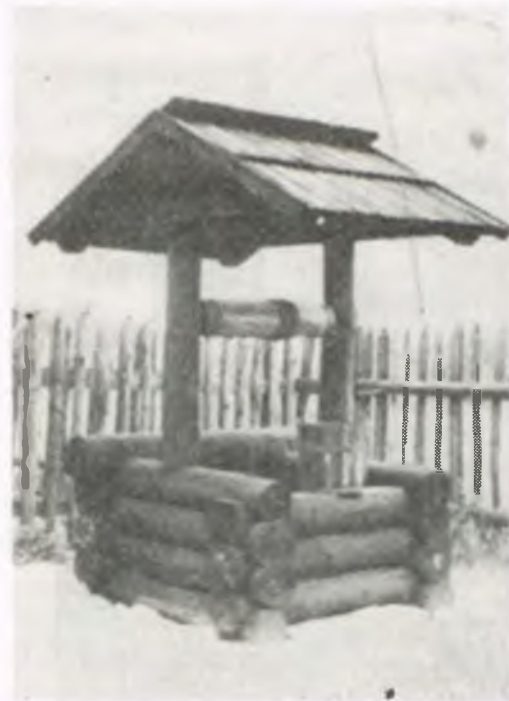
Studnia konstrukcji zrębowej w zagrodzie „gburskiej” (bogacza wiejskiego)
