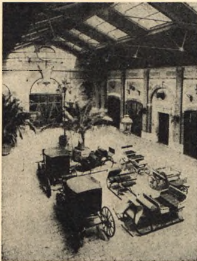
Widok ogólny hall zaprzęgowej
