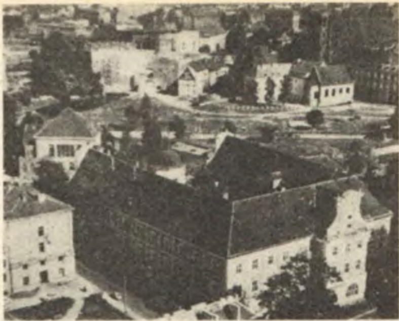
Budynek Biblioteki im. Ossolińskich
