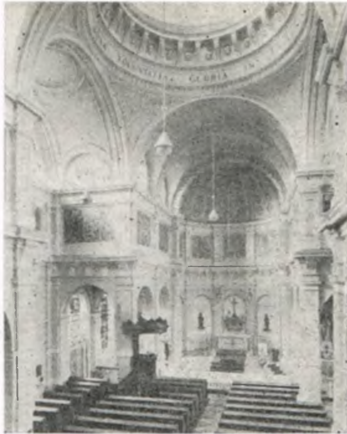
Wnętrze kościoła w Hilversum
