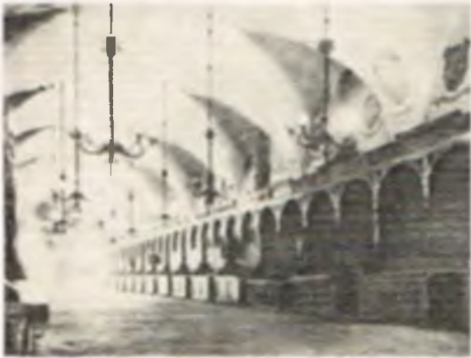
Wnętrze hali przyziemia Sukiennic
