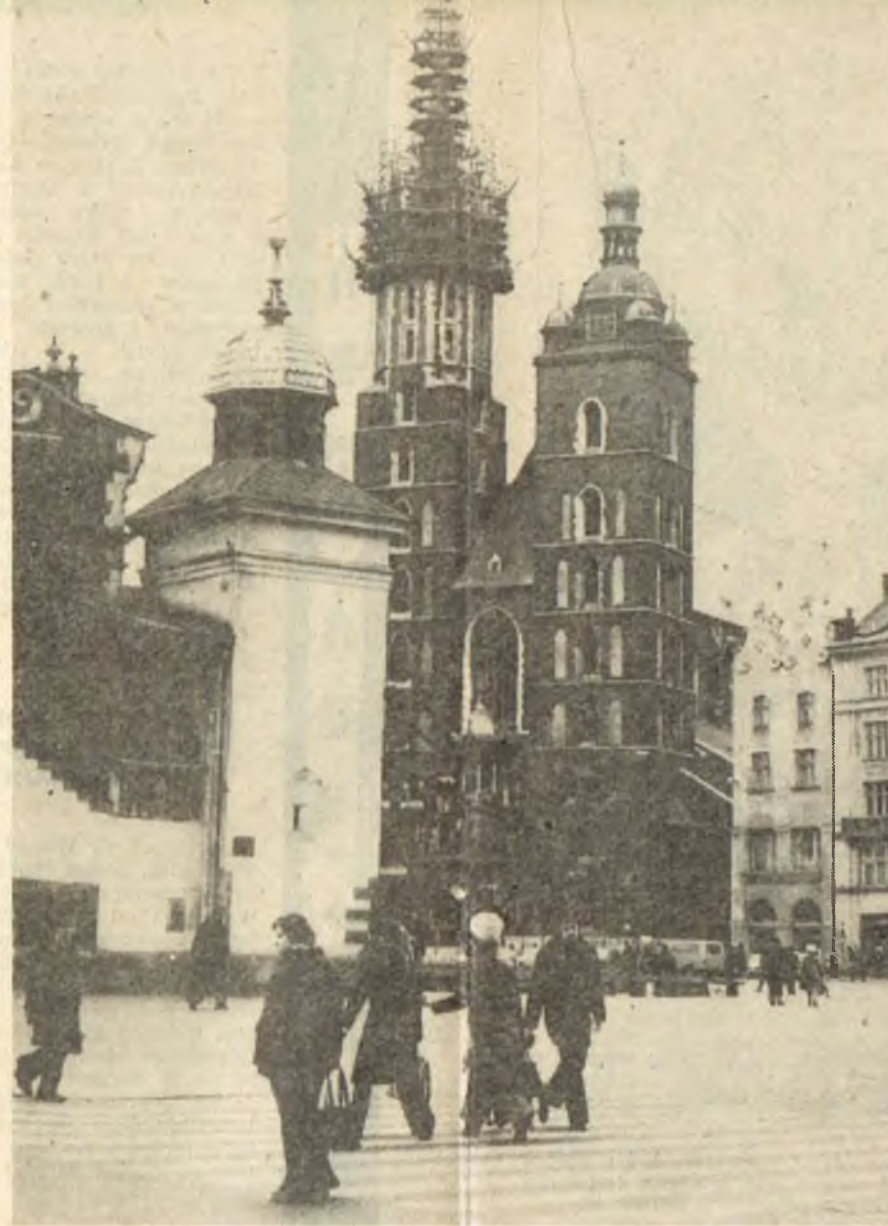
Kościół Mariacki. Zdjęcie wykonane podczas trwania remontu wieży kościoła
