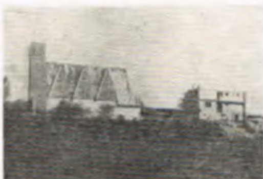
Zarki-Moczydło. Kościół i plebania w trakcie budowy
