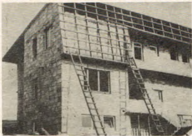
Plebania w budowie
