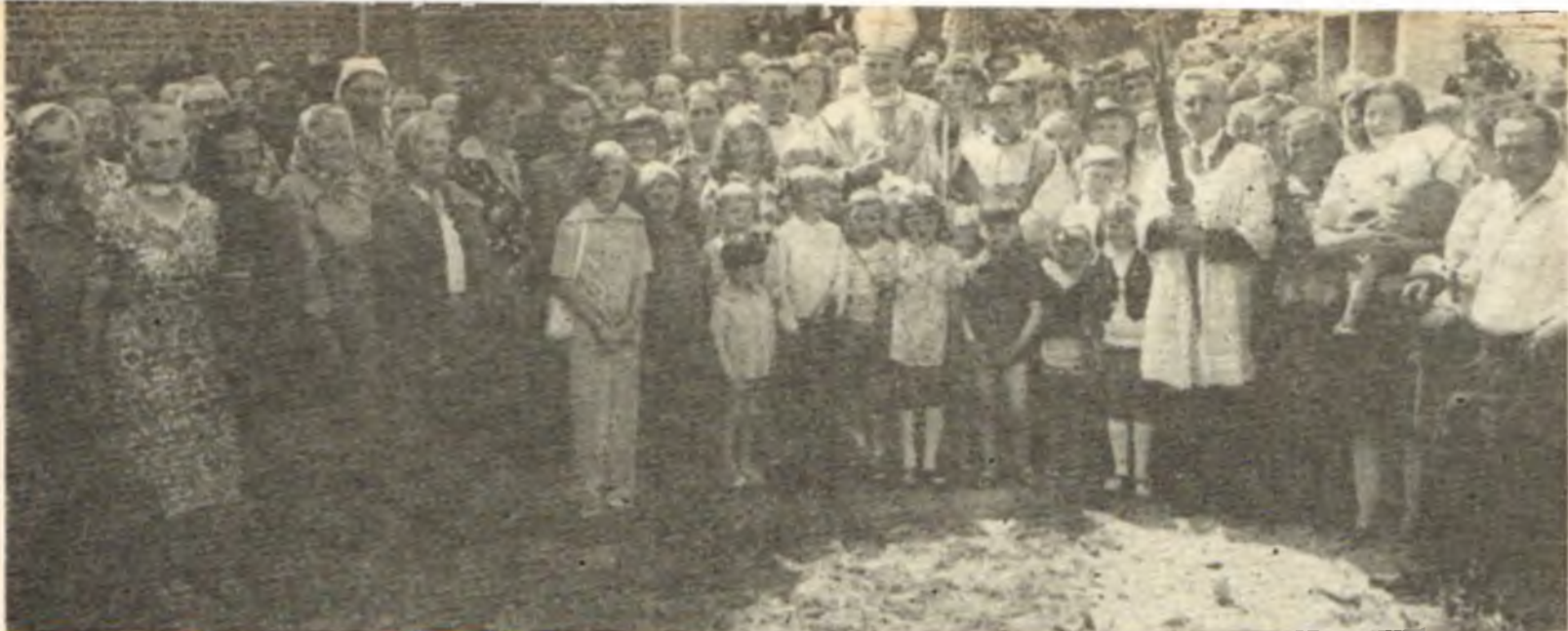
To zdjęcie zrobione zostało 28 marca 1976 r. W tym czasie parafianie świciechowski kończyli budowę swego nowego kościoła
