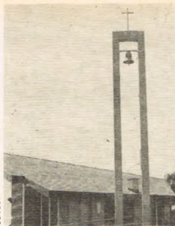
Neuchâtel. Nowoczesny obiekt sakralny kościół Starokatolickiego
