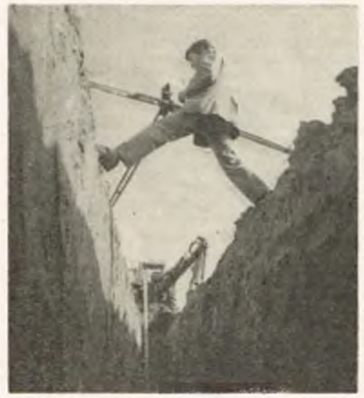
400 metrów drenów układa w ciągu godziny holenderska maszyna Tiel, należąca do przedsiębiorstwa melioracyjnego w Koninie. Nowoczesna, sterowana laserem maszyna pracuje z ogromną precyzją i nie wymaga dodatkowych, a uciążliwych obliczeń.
