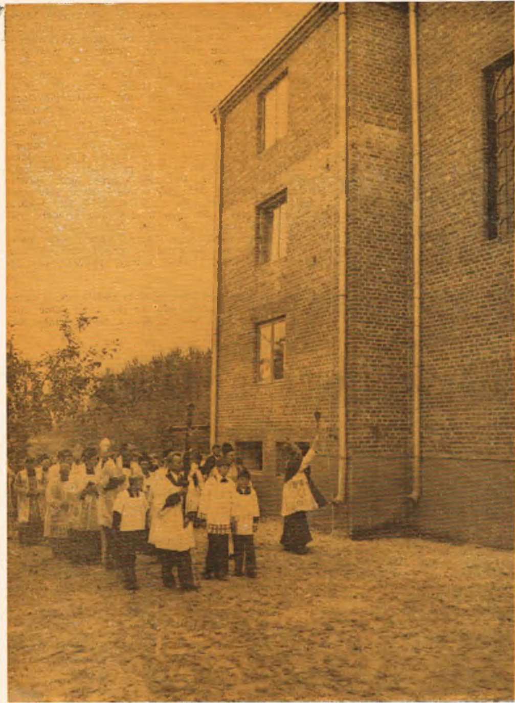
Poświęcenie murów kościoła z zewnątrz
