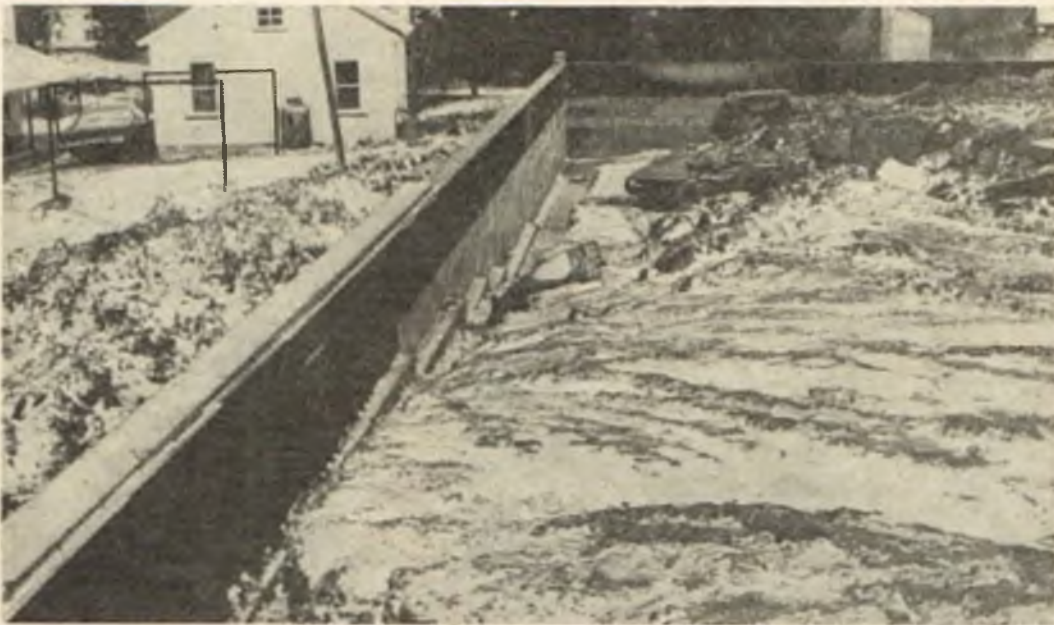
Tak wyglądało pierwsze stadium budowy Domu Opieki. Dziś prace budowlane są już poważnie zaawansowane
