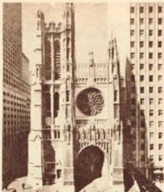
Monumentalna katedra Kościoła Episkopalnego p.w św. Tomasza w Nowym Jorku.
