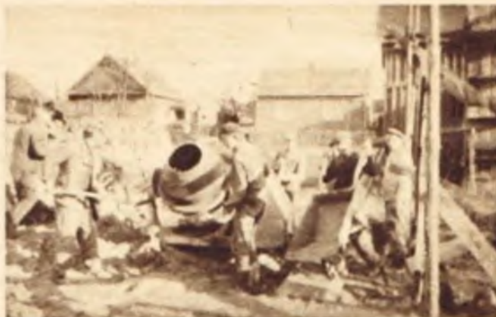
Budowa fundamentów pod nowy kościół parafialny w Świeciechowie. Fotograf — amator przeprasza czytelników „Rodziny” za słabą jakość fotografii, lecz wyraża nadzieję, że Świeciechowianie rozpoznają siebie na zdjęciach.
