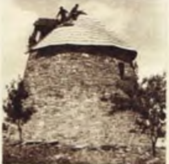
Trwa akcja „Ratujmy zabytki”. Na zdjęciu generalny remont wiatra.
