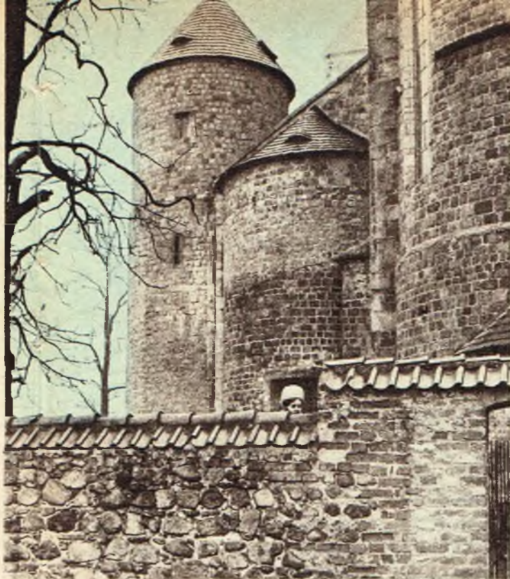
Widok na południowo-wschodni narożnik budowli
