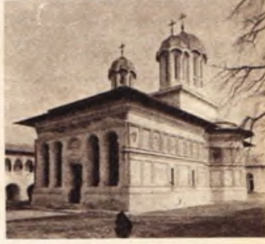
Kościół i klasztor w CALDARUSANI
