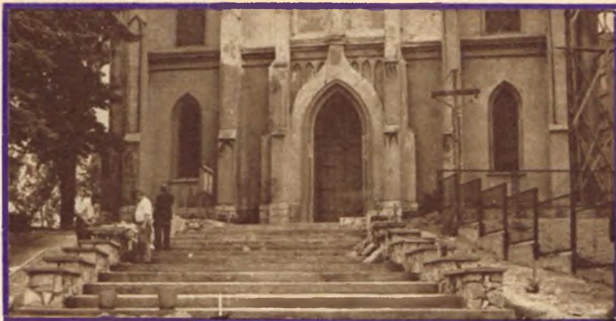
Schody przed kościołem polskokatolickim w Bolesławiu po generalnym remoncie.
