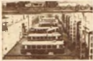
Zakłady Naprawy Autobusów w Słupsku. Jedno z największych przedsiębiorstw tego typu w kraju. Na zdj.: wszechstronnie wyposażona, nowoczesna hala remontowa.
