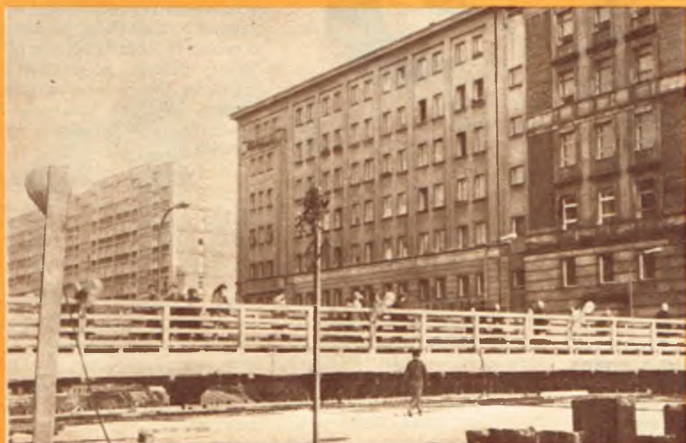
Skrzyżowanie ul. Marszałkowską. Poniżej pomostu dla pieszych widoczna zabetonowana płyta nad tunelem Trasy. Zakończenie prac budowlanych nastąpiło w połowie września. Obiekt ma być oddany do użytku w m-cu październiku.
