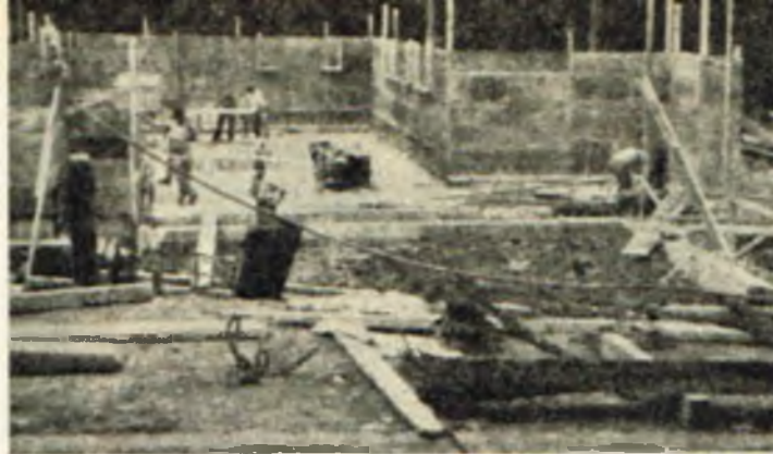
Kościół Chrześcijańsko-Katolicki (Starekatolicki) Szwajcarii buduje aktualnie Dom Młodzieży w Maribaj, K. G. G. Zdjęcie pokazuje aktualne zaawansowanie prac przy budowie tego domu.
