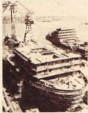
W Stoczni im. Komuny Paryskiej w Gdyni trwa budowa drugiego już 55-tysięcznika. Jest on przeznaczony dla armatora polskiego. Na zdj.: podczas montażu w suchym doku
