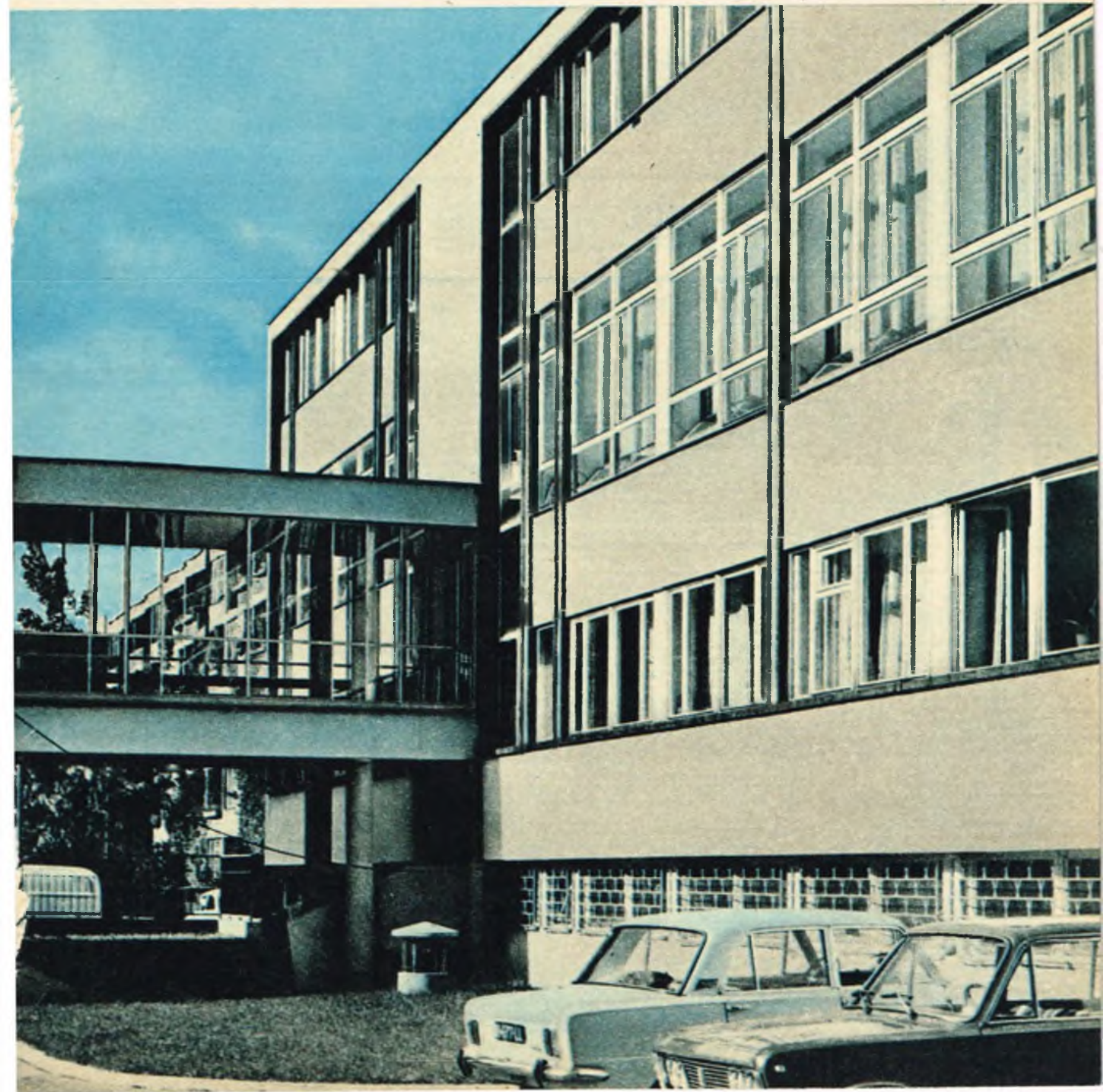
Budynek CHAT (widok od dziedzińca)
