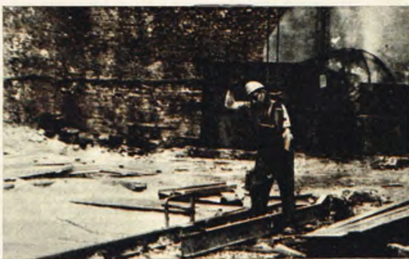
Przenoszenie elementów stalowych na poszczególne kondygnacje budynku.
