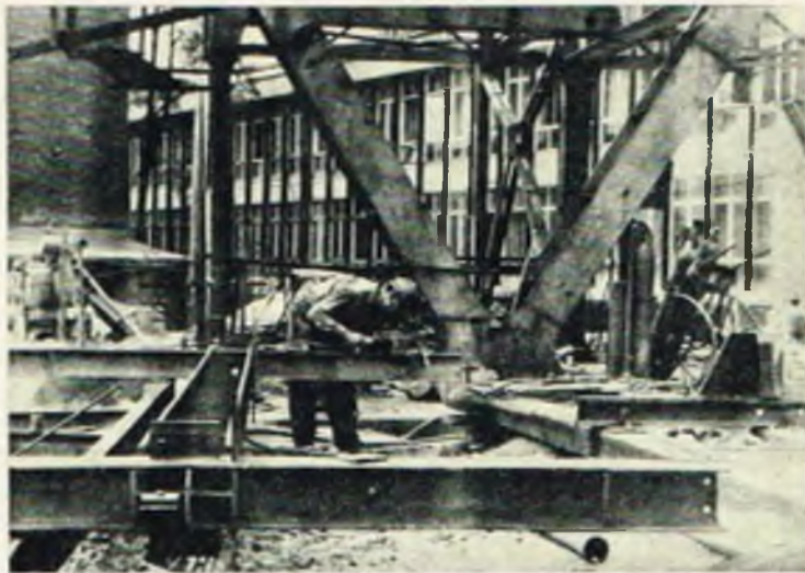
— Montaż elementów stalowych następnej kondygnacji.
